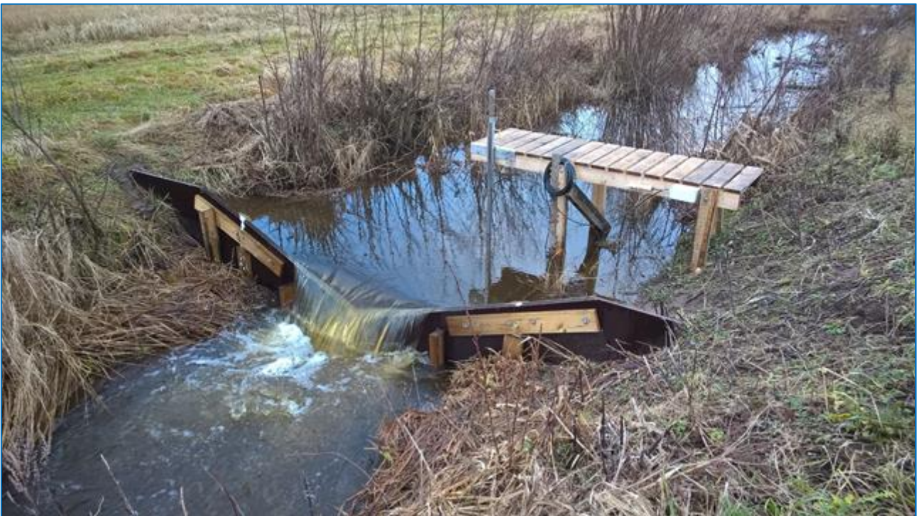
Kuva 1. Kaukanaranojan mitta-asema korkean virtaaman aikaan 11.12.2015. Kuva: S. Jaakkola
